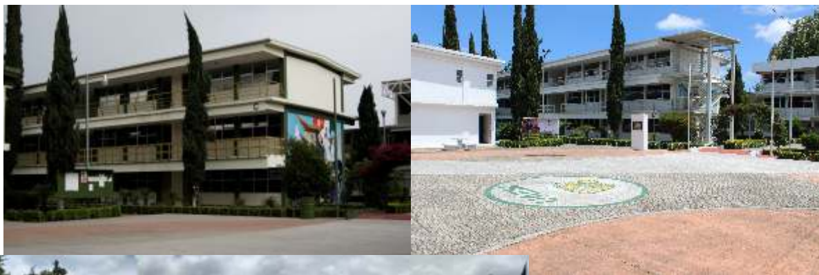
A la izquierda el edificio C; a la derecha nótese la escalera recién construida en el mismo edificio. Fotografía acervo fotográfico del plantel
