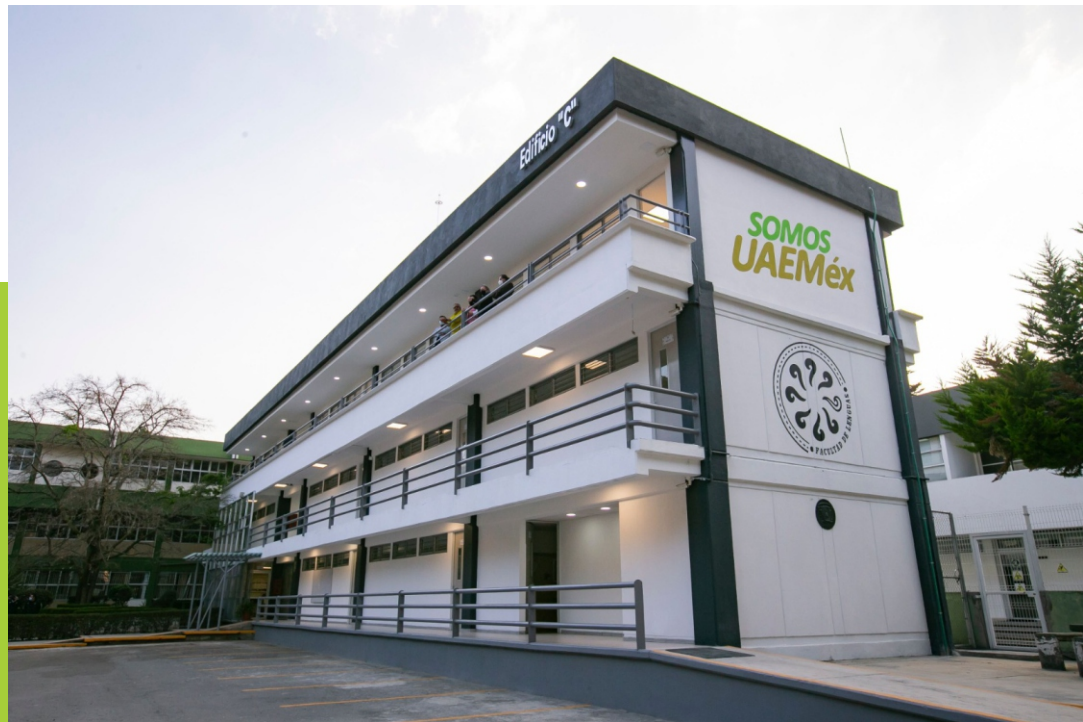
Fig. 1: Especial Portal. Edificio Facultad de Lenguas UAEMéx. 15 de marzo de 2023
