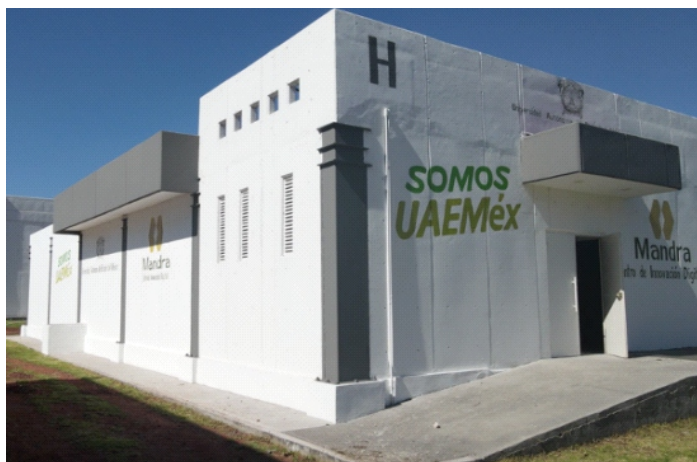
Figura 1.B. - Obra civil en funcionamiento, logo de MANDRA (Centro de Innovación Digital), UAEMex. (Imagen tomada de internet).
