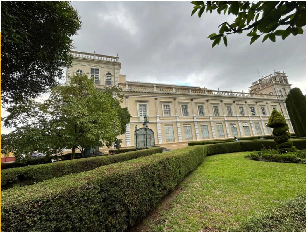
Fig. 1. UAEMéx, Edificio Histórico de Rectoría. Plaza de la Autonomía. Fotografía: Jonathan Yair Enríquez Zaragoza, agosto 2026
